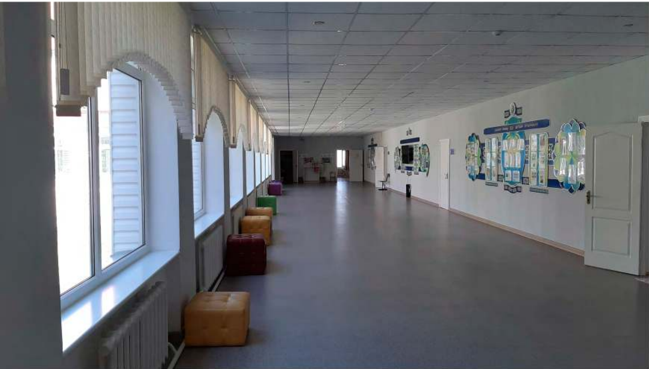
Коридор первого этажа
